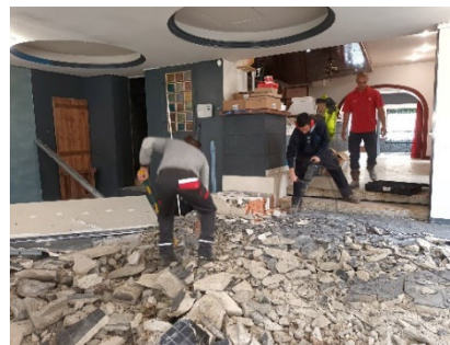
Démolition de la chape intérieure par nos services techniques pour création de l'accès aux personnes à mobilité réduite.
