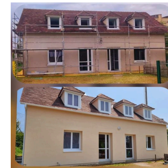
Isolation par l'extérieur de la M.A.M. réalisée par l'entreprise SOPEGO
